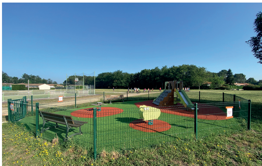
Aire de jeux : sol rénové.
